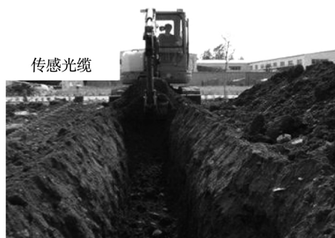
图4 挖掘机的挖掘行为
